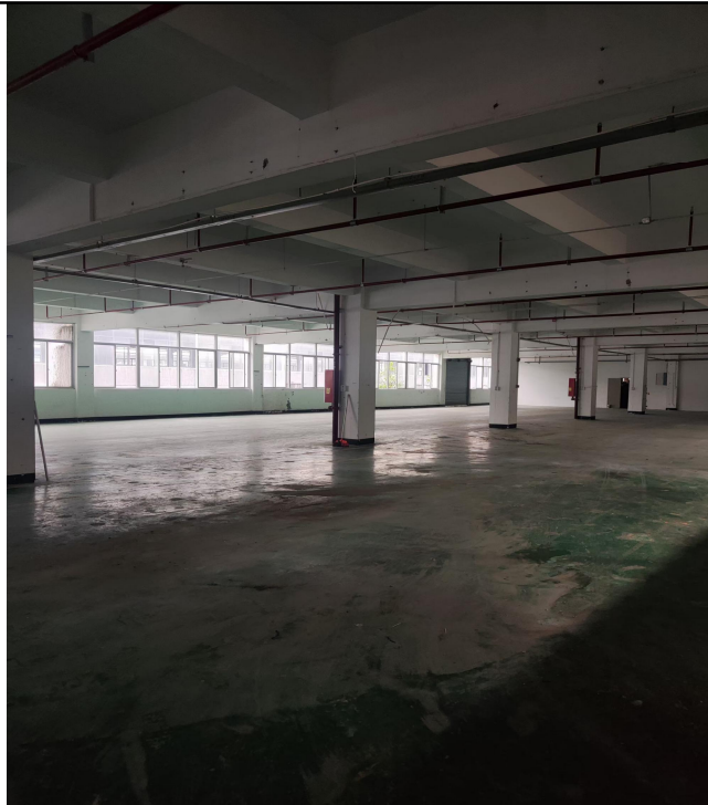
图 2.6-1 厂房现状照片
