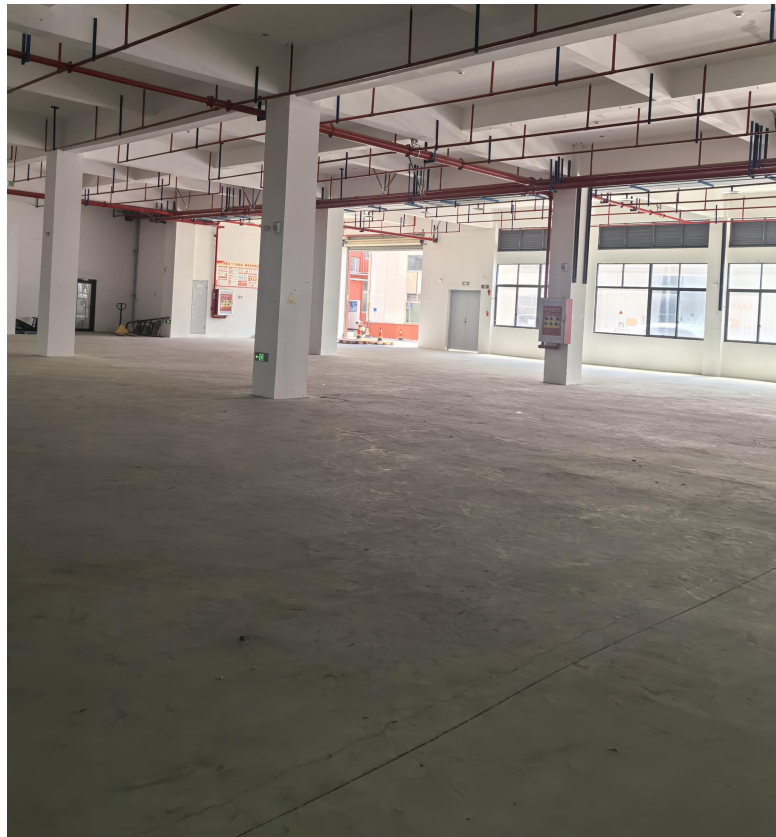
图 3-4 本项目车间硬化照片
